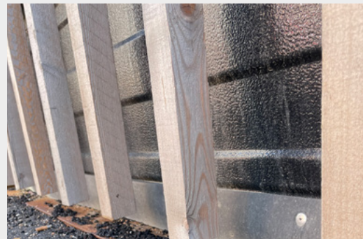
Den tekniske detalje mod terrænet er udført i neopren. Det er et vejrbestandigt og fleksibelt materiale
