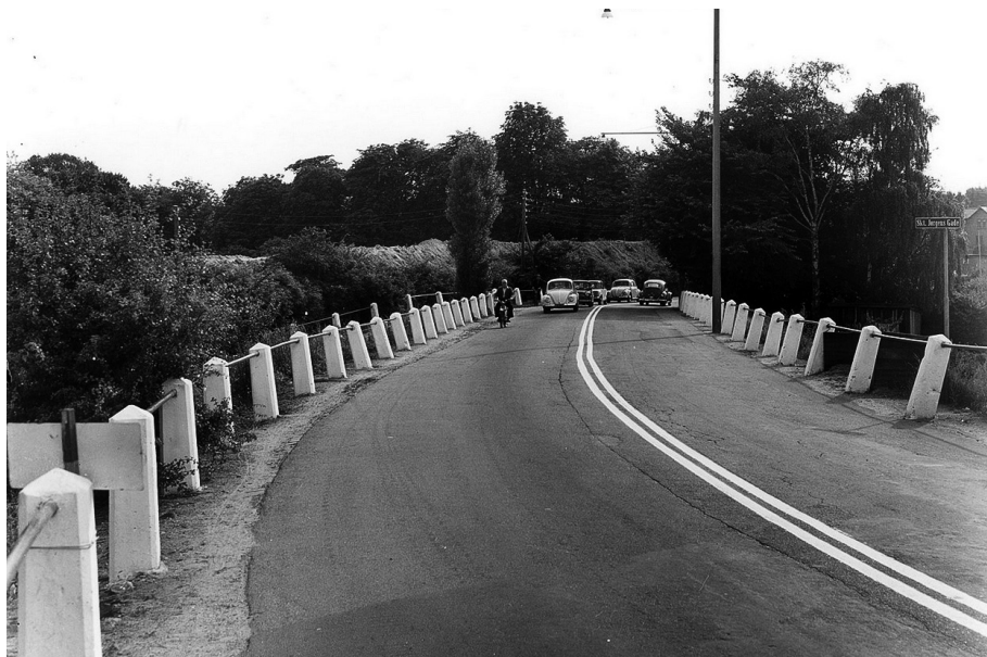
Figur 2. En mere moderne udgave af sikkerhedsrækværk havde erstattet kampesten med betonstøbte piller. De udgjorde dog stadig en stor fare ved påkørsel, som her ved overføring af jernbane i Sct. Jørgensgade i Odense i 1971 (Odense Stadsarkiv).
