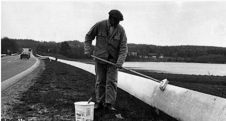
Figur 3. Maling af autoværn hører med til den jævnlige vedligeholdelse (Skanderborg Historiske Arkiv).
